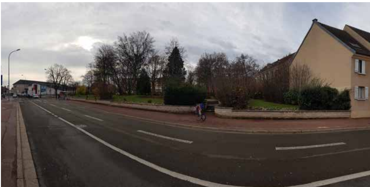
05 - Le parc est refermé sur lui-même à cause du mur de soutènement qui borde le boulevard André Malraux
