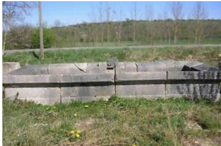
MARGELLE E BÉTON BLANC PLEINE MASSE
