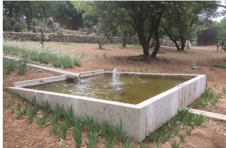
MARGELLE E BÉTON BLANC PLEINE MASSE
