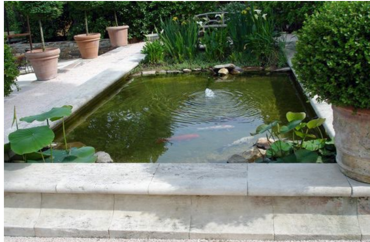
MARGELLE EN PIERRE PLEINE MASSE (ÉMERGENT DE 40CM MOYEN)
