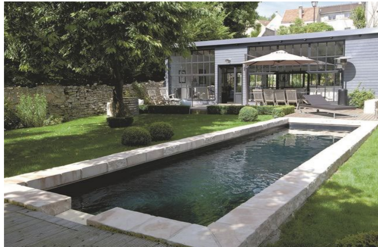
MARGELLE EN PIERRE PLEINE MASSE (ÉMERGENT DE 10CM MOYEN)
