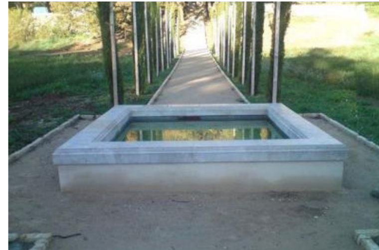
MARGELLE PIERRE ET MURET MAÇONNÉ ENDUIT
